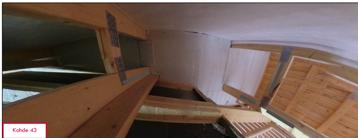
Kuva 16. Ristikot läpäisevät TVS:n ja osittain HVS:n. Harja kääntyy kohti rakennuksen pitkää sivua terassin puolella. Kuvassa oikealla alhaalla näkyy terassin sisäkaton harvalaudoitus. Rv=2015. Valokuvat: J-P Laakso / SPPL.
