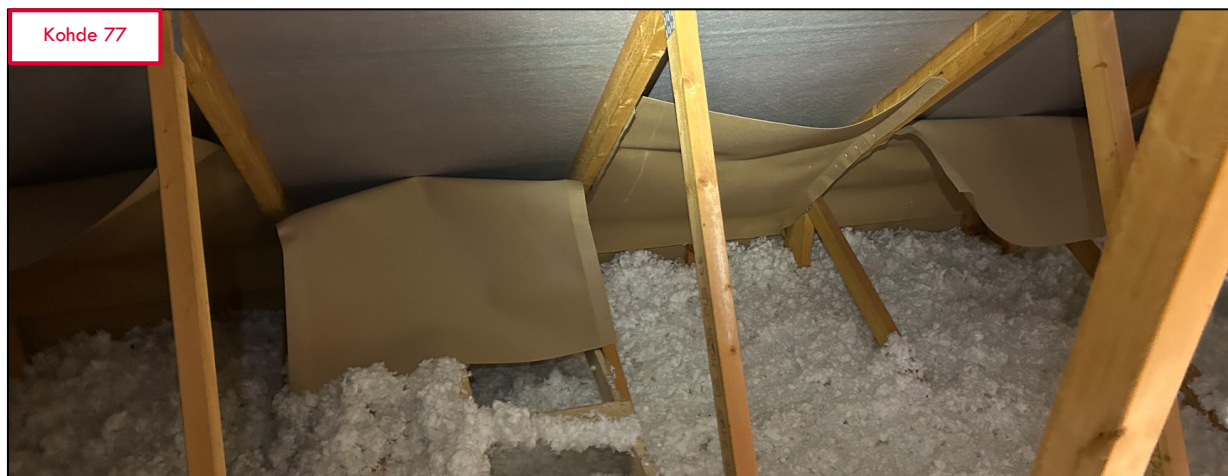
Kuva 97. Irronneita tuuliohjaimia. Tuuliohjainpahvit on kiinnitetty pelkästään nitojalla. Rv=2021. Valokuvat: J-P Laakso / SPPL.
