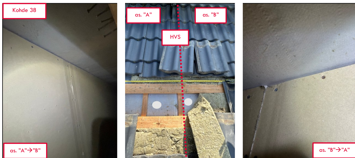
Kuva 30. Tiilikatteellisen rakennuksen HVS:n-VK:n liitos. Villatiivistys maksimoitu ja ulotettu kahden ristikon yli (n. 1200 mm). Keskellä AKV:n läpi kuultaa HVS:n levytykset. Huomion arvoista on, että HVS:n kohdalla on AKV:n tuuletus- rima, jolloin ruode ei pääse painumaan HVS:n kohdalla. Kattoristikko vieressä on taipuva rakennusosa, jolloin kattopohja painuu ristikon kohdalla, mutta ei HVS:n kohdalla. Rv=2019. Valokuvat: J-P Laakso / SPPL.
