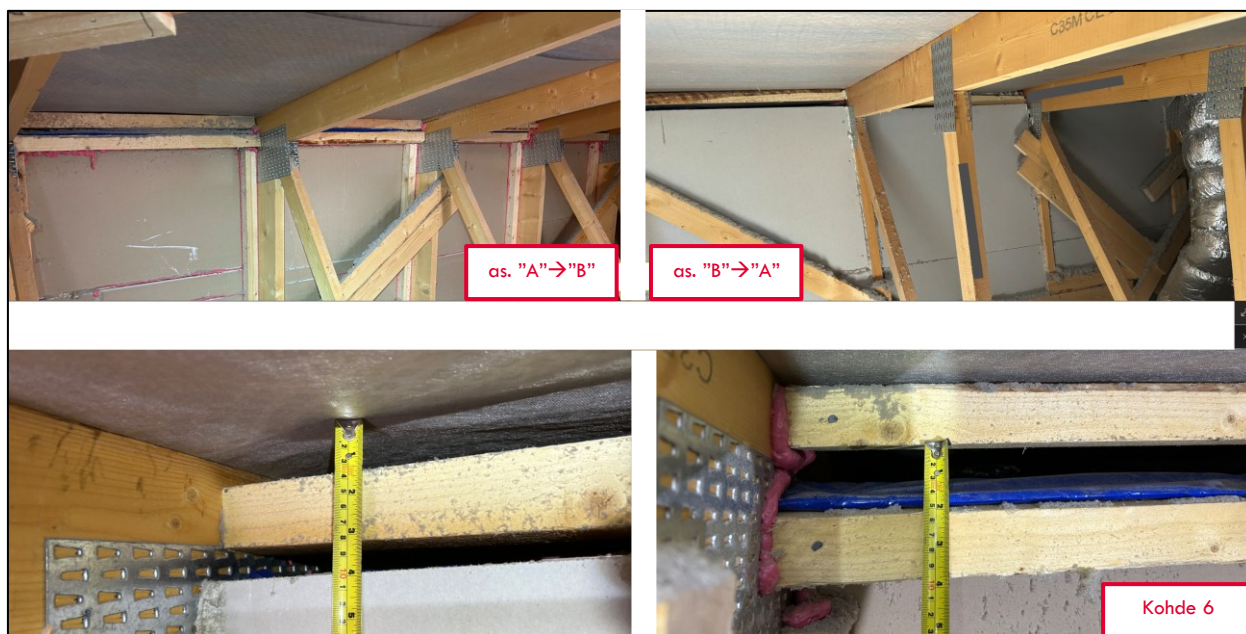
Kuva 17. Ristikkoa vasten kohtisuoraan toteutettu palo-osastointi seinän molemmin puolin. Sama ristikko jatkuu molemmin puolin seinää. Tuuletusrakoon asennettu paisuva palokatkonauha. Tukilankun ja vesikatteen välissä rako (aluskate nousee mitan päällä työntämällä). Rv=2021. Valokuvat: J-P Laakso / SPPL.
