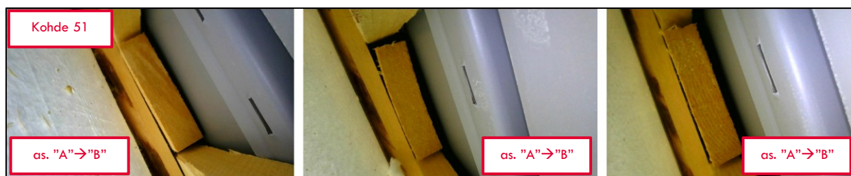
Kuva 51. Kapuloinnissa havaitaan puun luonnollista elämistä, sekä rakoja asennuksessa (mittaepätarkkuutta).
