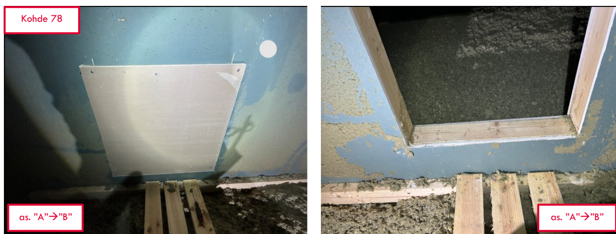
Kuva 68. Rakennuspaikalla tehty luukku palo-osastoivan seinän läpi. Aukko (n. 60x50cm) peitetty kahdella kipsilevyllä (70x70cm), jotka kiinnitetty yhteensä viidellä ruuvilla. Levyvalmistajilla on ohjeet kipsilevyjen asianmukaiseen kiinnitykseen. Esimerkiksi Gyproc-käsikirjassa reunoilla max kiinnikeväli on 200 mm (34 s. 14). Rv=2019. Valokuvat: J-P Laakso / SPPL.
