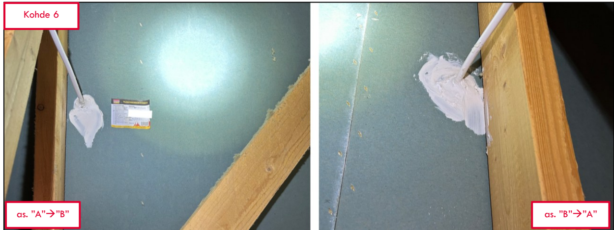
Kuva 82. MMJ-läpivienti, joka tiivistetty palokatkotuotteella. Tuotemerkintä, asentaja ja päiväys kirjattu tarraan. Rv=2020. Valokuvat: J-P Laakso / SPPL.
