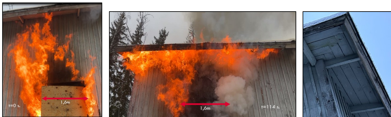
Kuva 54. Kuvakaappaus videolta, jossa havainnollistetaan räystäiden palokäyttäytymistä ja liekkien leviämistä tavanomaisen mittaisessa räystäskainalossa. Aika ( t=0 ) on savukaasujen syttymisen hetki. Noin kahden minuutin ( t=114 s) kohdalla liekit ovat levinneet noin kolminkertaiselle leveydelle aukkoon verrattuna. Valokuvat: J-P Laakso / SPPL.
