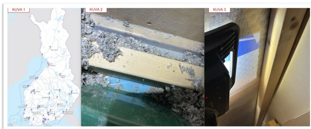
1) Kohdekäyntien maantieteellinen jakauma. 2) Välikatot ja ullakon limitetty liitos (TOPTEN-pientalon palokortin mukainen). 3) Vesikatot ja ullakon palo-osastoivan seinän kivivillalla tiivistetty liitos (TOPTEN-pientalon palokortin mukainen). Kuva: Juhan-Petteri Laakso, Suomen Palopäälystöliitto
