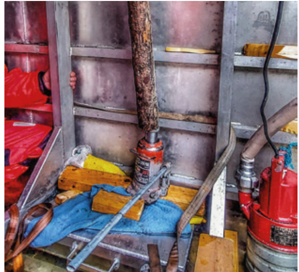
Vuotokohdan tiivistäminen pullotunkin avulla.
